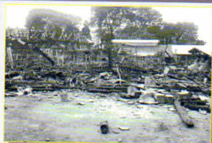
寺町工場 昭和14年。 火災が起きた本社工場。
